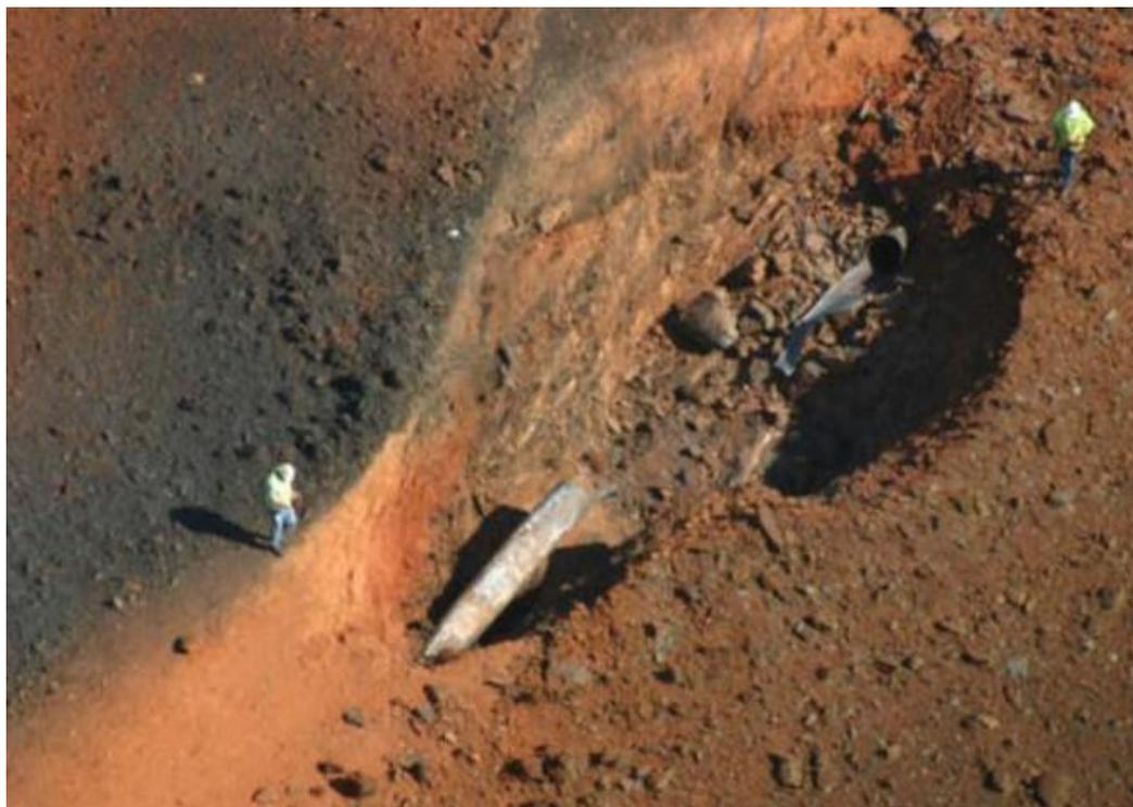
Рисунок 1.22 – последствия аварии на магистральном газопроводе в г.Гринсберг
